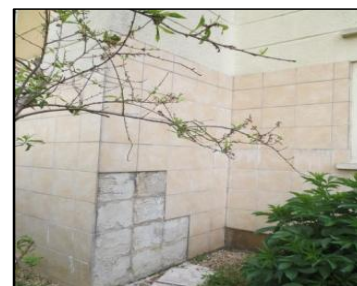
Photo N° 53 ECH-N°29 -1R+4 - Esc.2-3J.SIEG. Façades Murs Colle faïence
