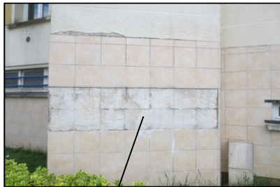
ECH-N°33 -1R+4-Esc.5-6J.SIEG.-Façades/Murs Colle faïence , (photo n° 90)
