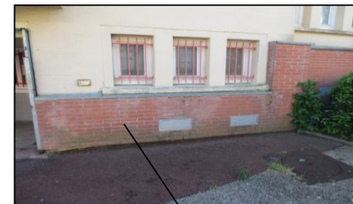
ECH-N°3 -1R+8-BAT.13 - Façade/Murs Colle briques rouge, (photo n° 4)
