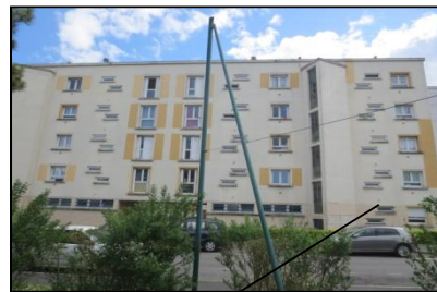
ECH-N°34 -1R+4-Esc.5-6J.SIEG.-Façades/Murs Mortier + peinture, (photo n° 62)
