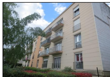
ECH-N°26 -1R+3-Esc11-12 Ribot Façades/Murs Mortier + peinture, (photo n° 42)
