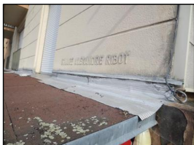
Photo N° 79 ECH-N°15 -1R+4 - Esc.1-2 Toits commerces Etanchéité Toiture Pax alu
