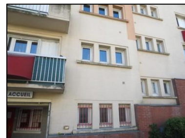
Photo N° 3 ECH-N°2 -1R+8 - BAT.13 Façade Murs Mortier + peinture
