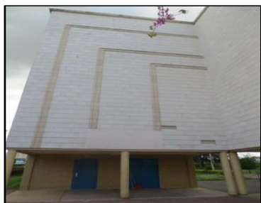
Photo N° 69 ECH-N°38 -1R+4 - Esc.8-9 J.SIEG. Pignons Etanchéité - Plaques Polystyrène + colle + plaque
