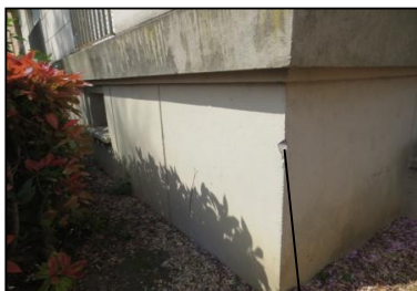
ECH-N°25 -1R+3-Esc11-12 Ribot Façades/sousbassement Mortier + peinture, (photo n° 86)
