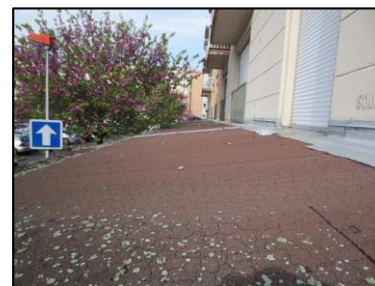
Photo N° 78 ECH-N°14 -1R+4 - Esc.1-2 Toits commerces Toiture Shingle
