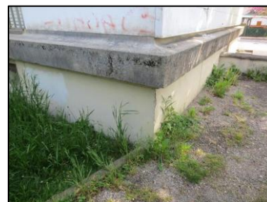
Photo N° 84 ECH-N°22 -1R+3 - Esc.8-9 Ribot Façades Soubassement - Murs Enduit + peinture
