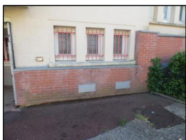
Photo N° 4 ECH-N°3 -1R+8 - BAT.13 Façade Murs Colle brique rouge
