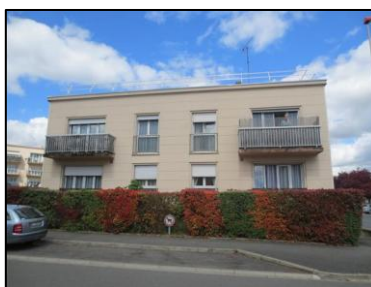
Photo N° 45 ECH-N°8 -1R+1- Bat.4 Calmette Façade Murs Enduit + peinture
