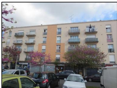
Photo N° 16 ECH-N°13 -1R+4 - Esc.1-2 Ribot Façades - Murs Peinture
