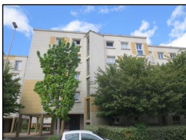
Photo N° 47 ECH-N°30 -1R+4 - Esc.1J.SIEG. Baie vitrée escalier Baies vitrées Mastic
