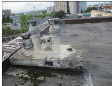
Photo N° 108 ECH-N°44 AMIANTE CIMENT -1R+4 - Esc. 1J.SIEG. Toiture Conduit de cheminée Conduit gris
