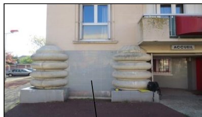
ECH-N°1 -1R+8-BAT.13 - Façade/Murs Colle faïence grise, (photo n° 2)
