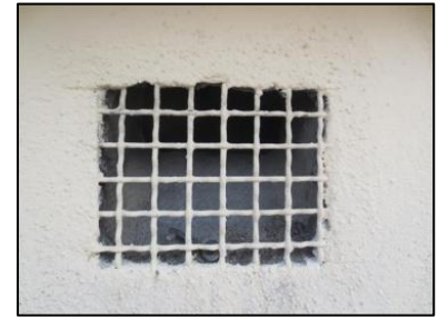
Photo N° 106 AMIANTE CIMENT -1R+8 - BAT.13 Toiture Conduits de ventilation Ventilation haute (Fibres-ciment)
